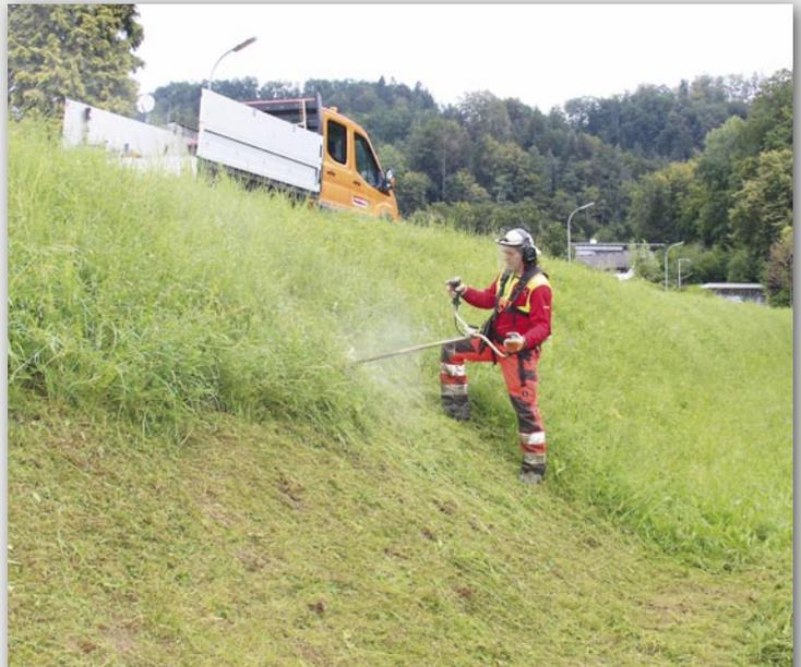
Steile Böschungen müssen per Hand gemäht werden.
